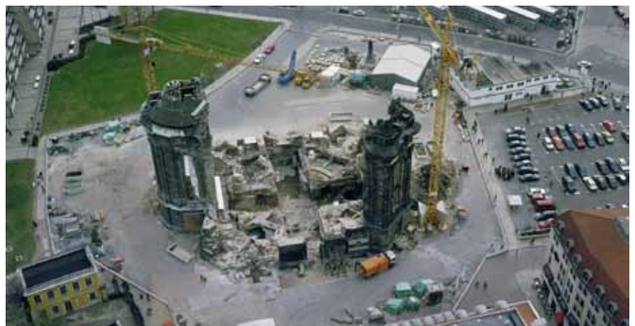
Oben: Trümmerberg zu Beginn der archäologischen Enttrümmerung mit Planquadraten zur Fundortung, Frühjahr 1993, unten: nach der archäologischen Enttrümmerung, September 1994.
