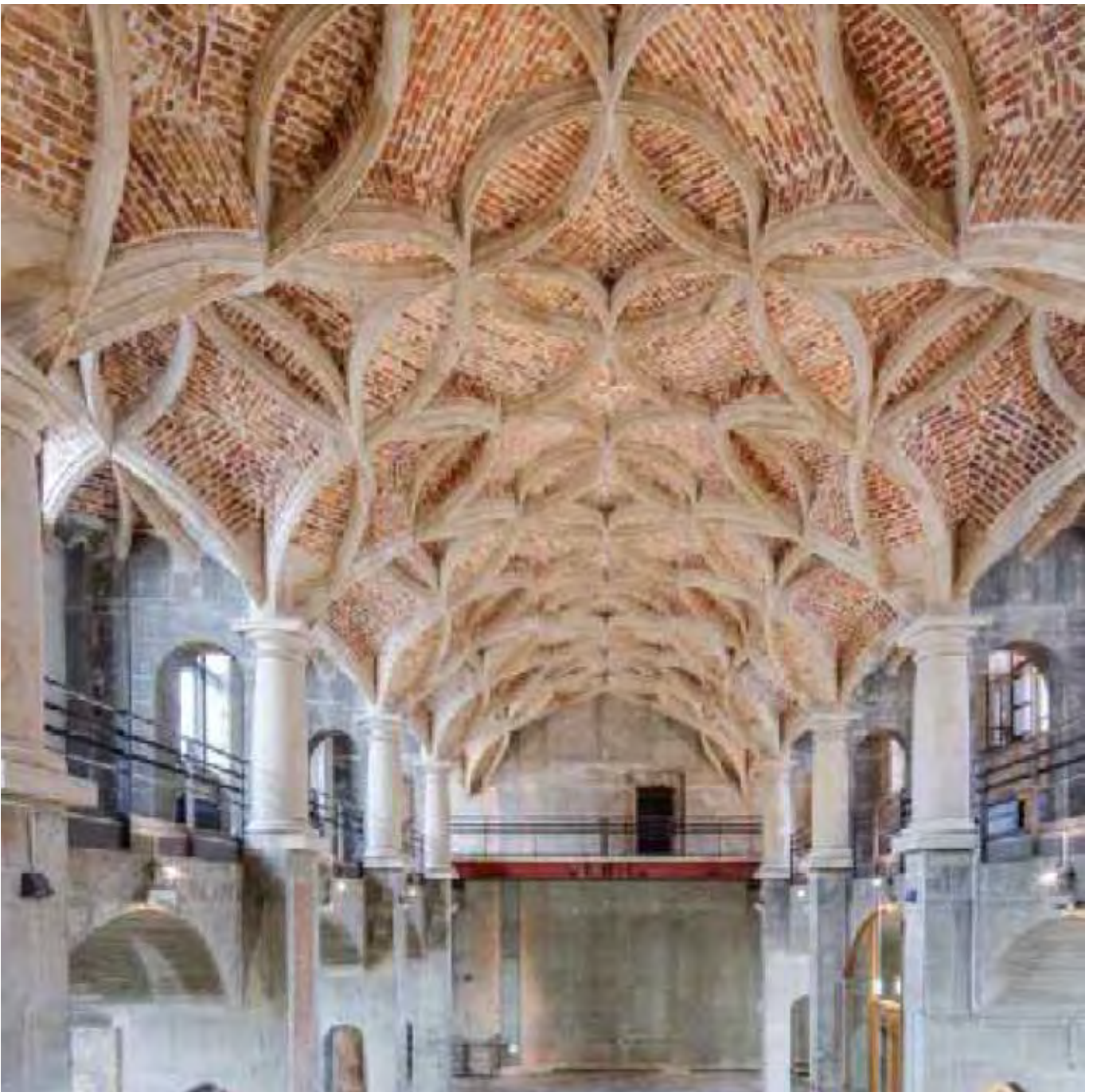
Oben: Dresdner Schlosskapelle, Kupferstich von David Conrad (1604–1681), 1676, unten: Schlingrippengewölbe der Dresdner Schlosskapelle, 2013.
