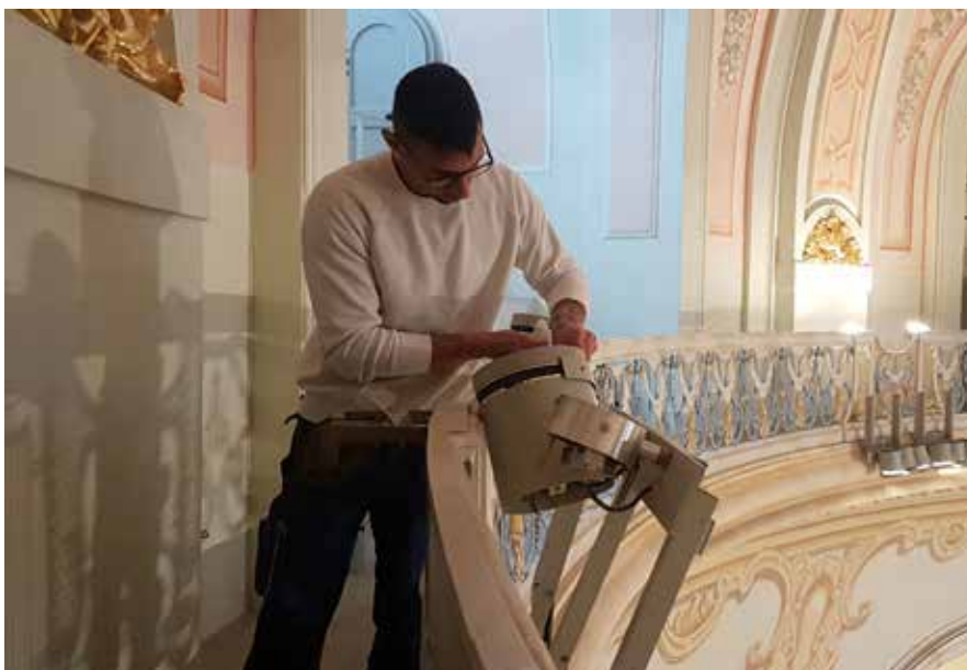
Schließwoche 2019 (S. 8 unten: Tischler bei der Nachbearbeitung des Gestühls im Kirchenschiff, S. 9 oben: Lutz Pesler bei Reinigungsarbeiten am Taufbecken, S. 9 unten: Elektriker bei Wartungsarbeiten an der Hauptraumbeleuchtung), 7.1.2019.
