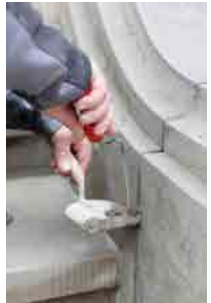
S. 9 unten links: schadhafte Fuge an einer Treppenwange, 15.4.2021; Verfugungsarbeiten (S. 8 oben und 9 unten rechts, 19.5.2021; S. 8 unten: 25.5.2021).
