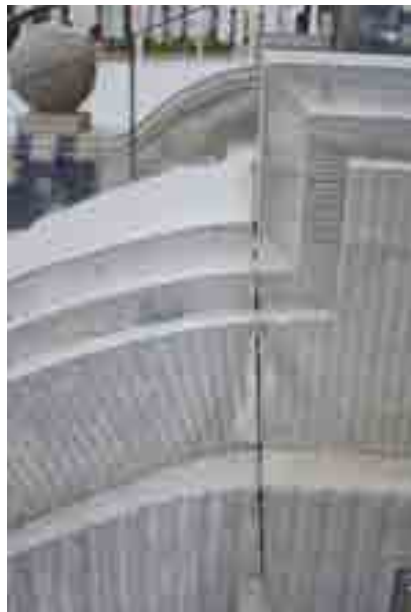
S. 9 unten links: schadhafte Fuge an einer Treppenwange, 15.4.2021; Verfugungsarbeiten (S. 8 oben und 9 unten rechts, 19.5.2021; S. 8 unten: 25.5.2021).
