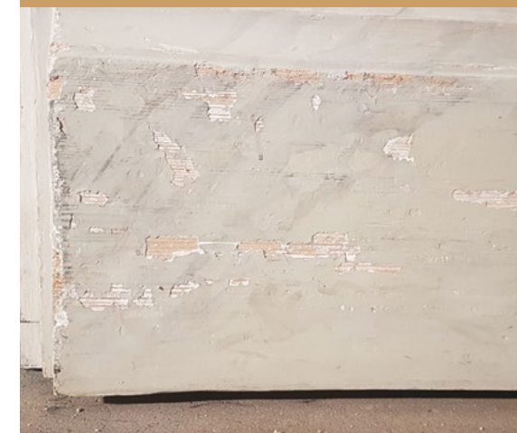
Während der Schließwoche werden stark beschädigte Farbfassungen an den Türen behoben.
