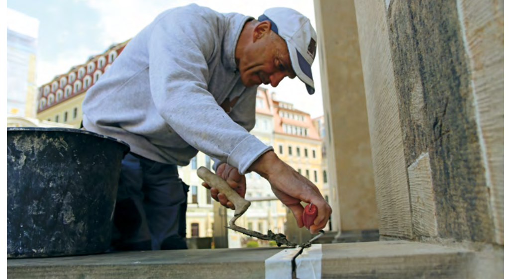
Die die Sockelsteine witterungsbedingt starker Beanspruchung ausgesetzt sind, wurden Verfugungen erneuert.
