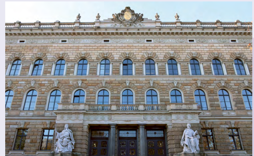
Im Justizzentrum Roßbachstraße befinden sich sowohl das Amts- als auch das Landgericht Dresden. Hier wird in Zivil- und Strafsachen entschieden.
