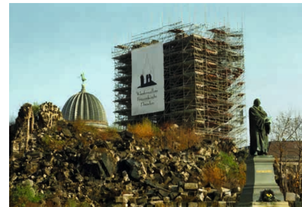
Dresden-Altstadt, Frauenkirche | Konstruktive Sicherung der Chorapsis, November 1992
